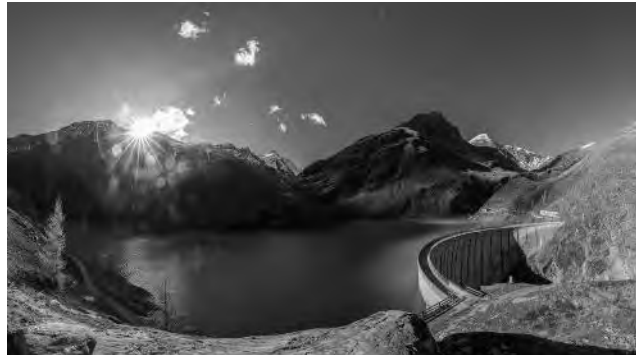
Abb. 20: Staumauer des Margaritzenstausees (Großglockner)/Österreich © D. Meyrl/Getty Images Plus
